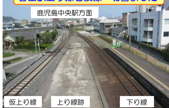
谷山駅上り線を仮線へ切替ました
