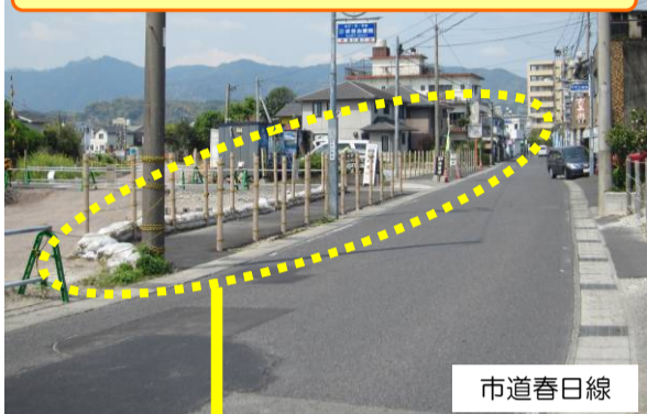
自転車・歩行者用通路を整備しました
