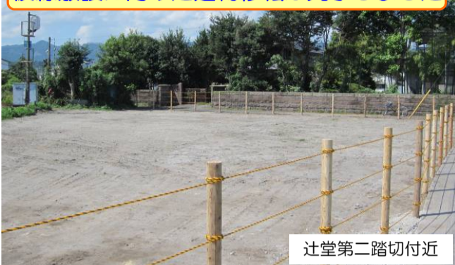
仮線敷設に向けた建物移転が完了しました
