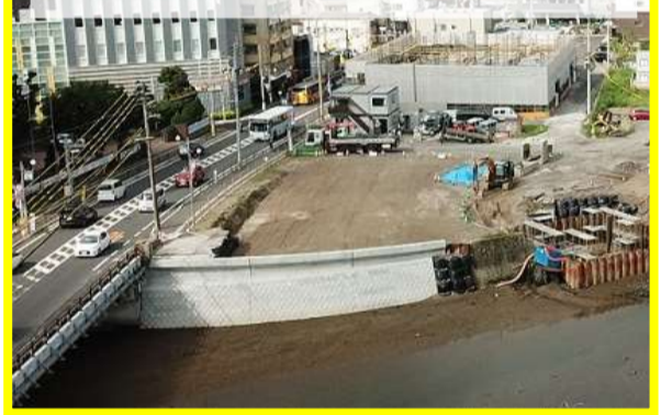
③ 道路擁壁(1工区)の工事が完了しました。
