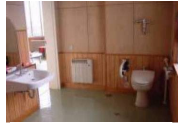
車いすで方向転換ができるスペースを確保したトイレ 【秋田県男鹿市立北陽小学校】
