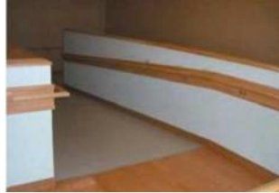
廊下と材質が異なり分かりやすいスロープ 【京都府京都市立涉成小学校】
